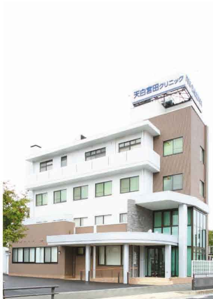
「天白宮田クリニック」は通行量の多い国道153号線沿いにあり、クリニック名の入った大きな看板が目印だ。4階建ての建物の中には入院設備も兼ね備えている。
